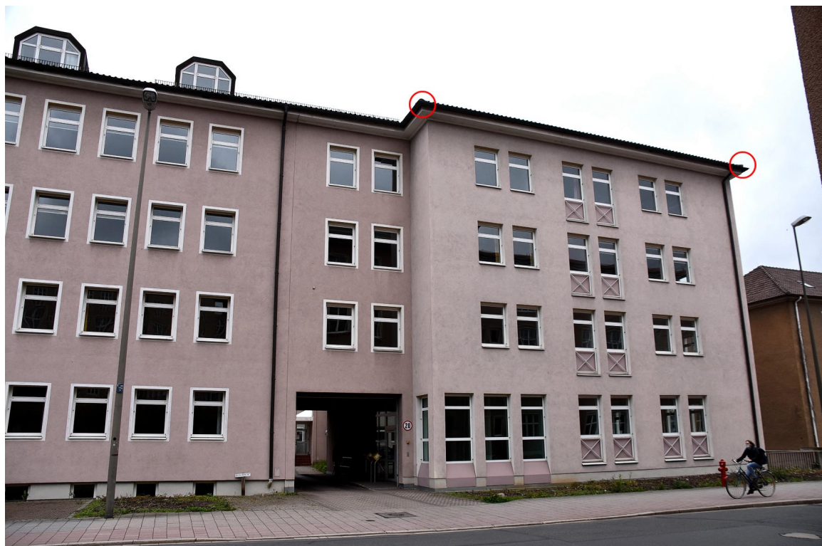
Abb. 2: Gebäude Sieboldstr. 14 mit der Position der Sperlingsbrutplätze, rot markiert (Foto FEHSE 20.05.2021)
